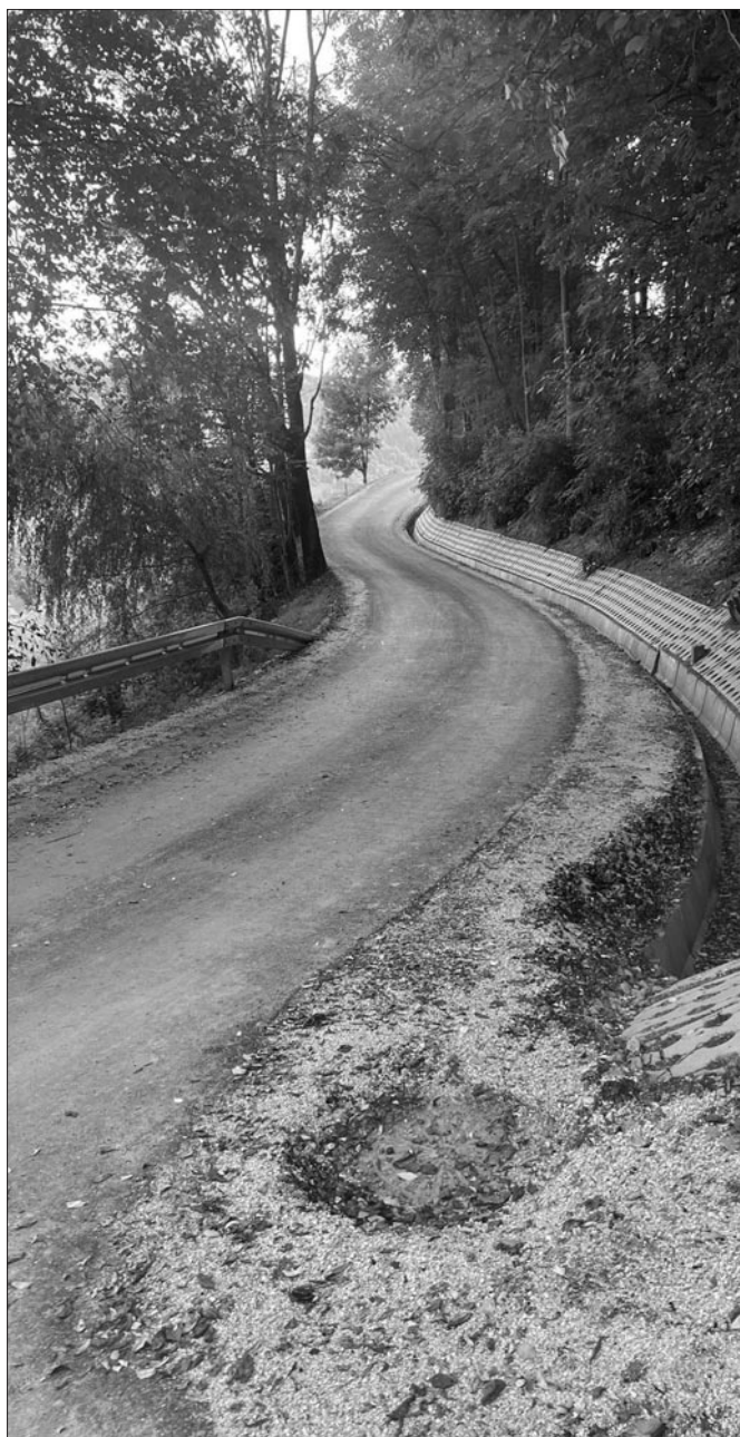
Droga do osiedla Jadamy w Łętowie
