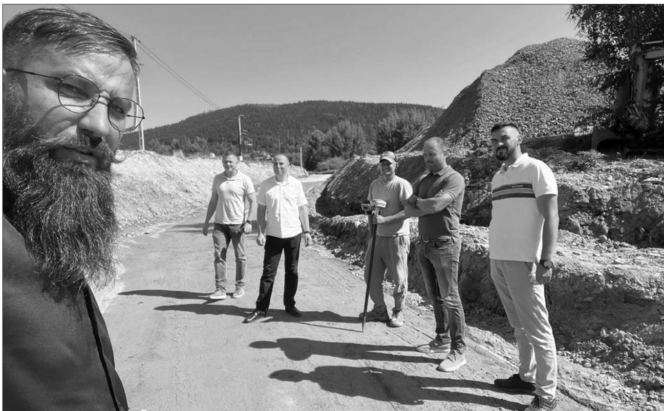
Rada budowy drogi Szymony-Gruszowiec w terenie
